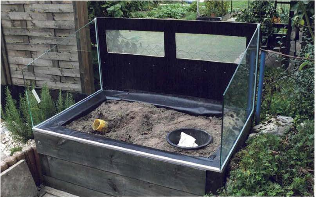
Abb. 6: Rückwand und Seitenteile sind bereits eingefügt. Die Folien über dem Holzfundament sind noch zu sehen. Foto: M. HALLMEN
