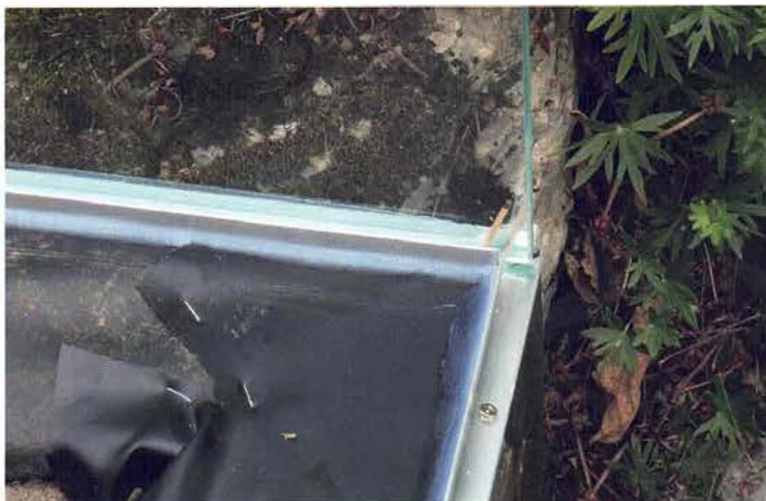
Abb. 6: Die Scheiben werden mit Silikon in den U-Profilen verklebt. Foto: M. HALLMEN
