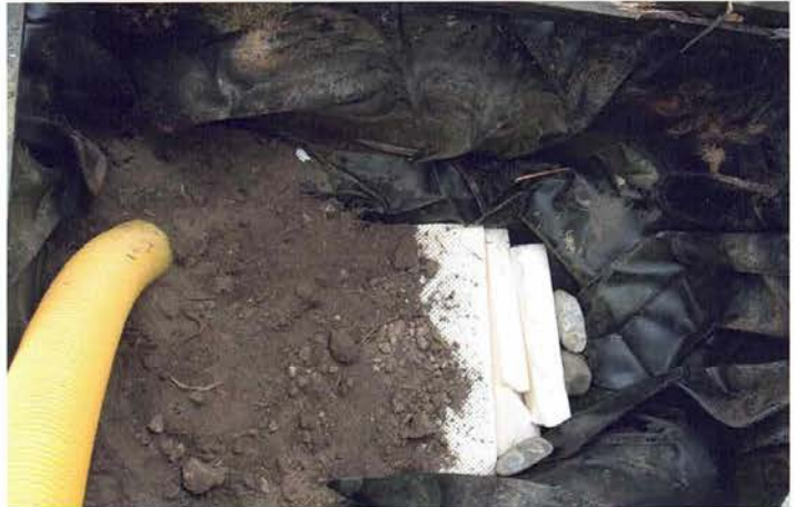
Abb. 5: Das Überwinterungsquartier wurde mit einer festen Styrodur-Platte abgedeckt und mit einem Drainagerohr für die Schlangen zugänglich gemacht. Foto: M. HALLMEN
